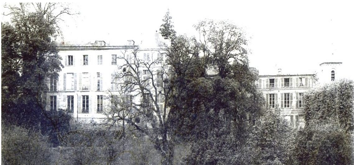
Cliché de 1982 : on reconnaît la grosse tour carrée et l'église ; Entre les deux est le rajout du chevalier de Bignon vers 1780 (© Yves Aven)
