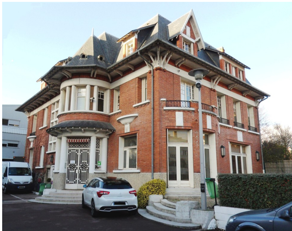
3bis rue Lakanal (cliché L. Sillon)
