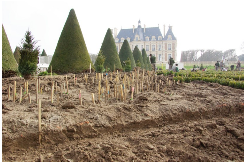
21 novembre 2012, réalisation des premières implantations du parterre haut (crédit photo : CG92) droits réservés
