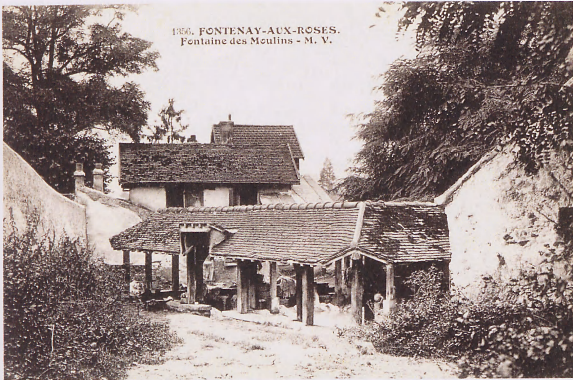
Le lavoir de la Fontaine des Moulins dans sa configuration de 1832, vu vers 1910 (© Coll. HistoriCités).
