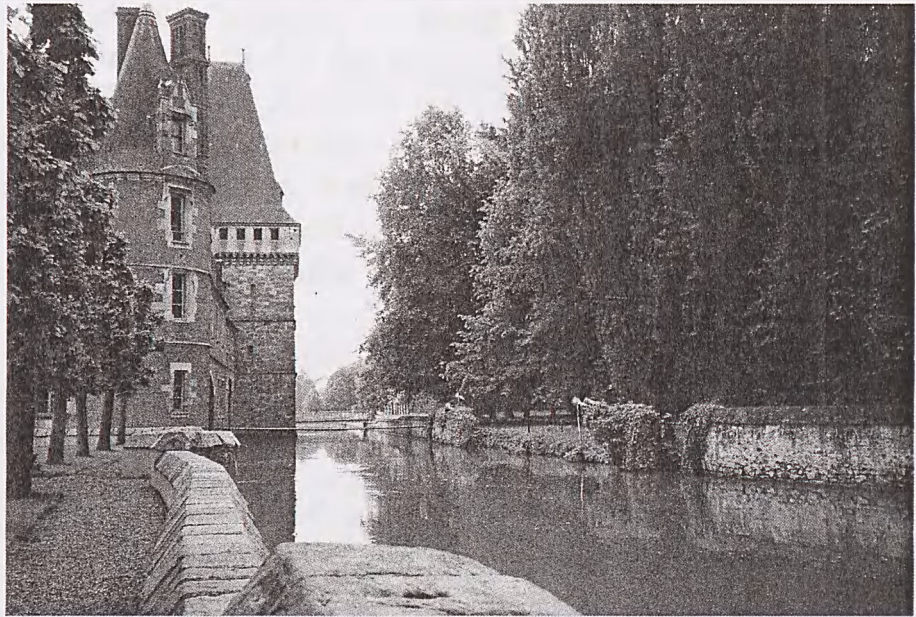
Perspective du bras d'eau vers l'aqueduc, vue de la Cour d'entrée du château
