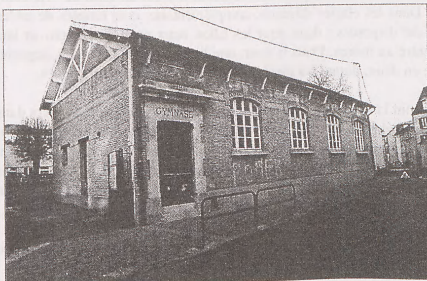
Le gymnase, aujourd'hui démolé et remplacé par un immeuble rue des Imbergères - Photo MJC
