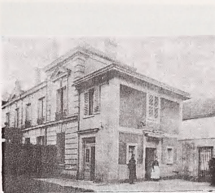
1857. Bâtiment construit par M. Pigornet pour la Conservation des Hypothèques, le long de la rue de Penthièvre.
